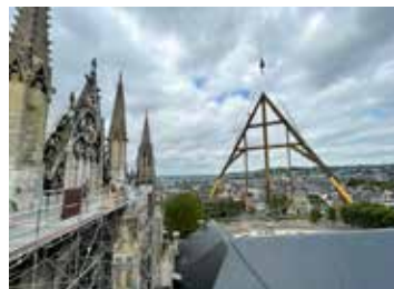
Élément de charpente déposé lors de la restauration © B.ELiot-Octopus
